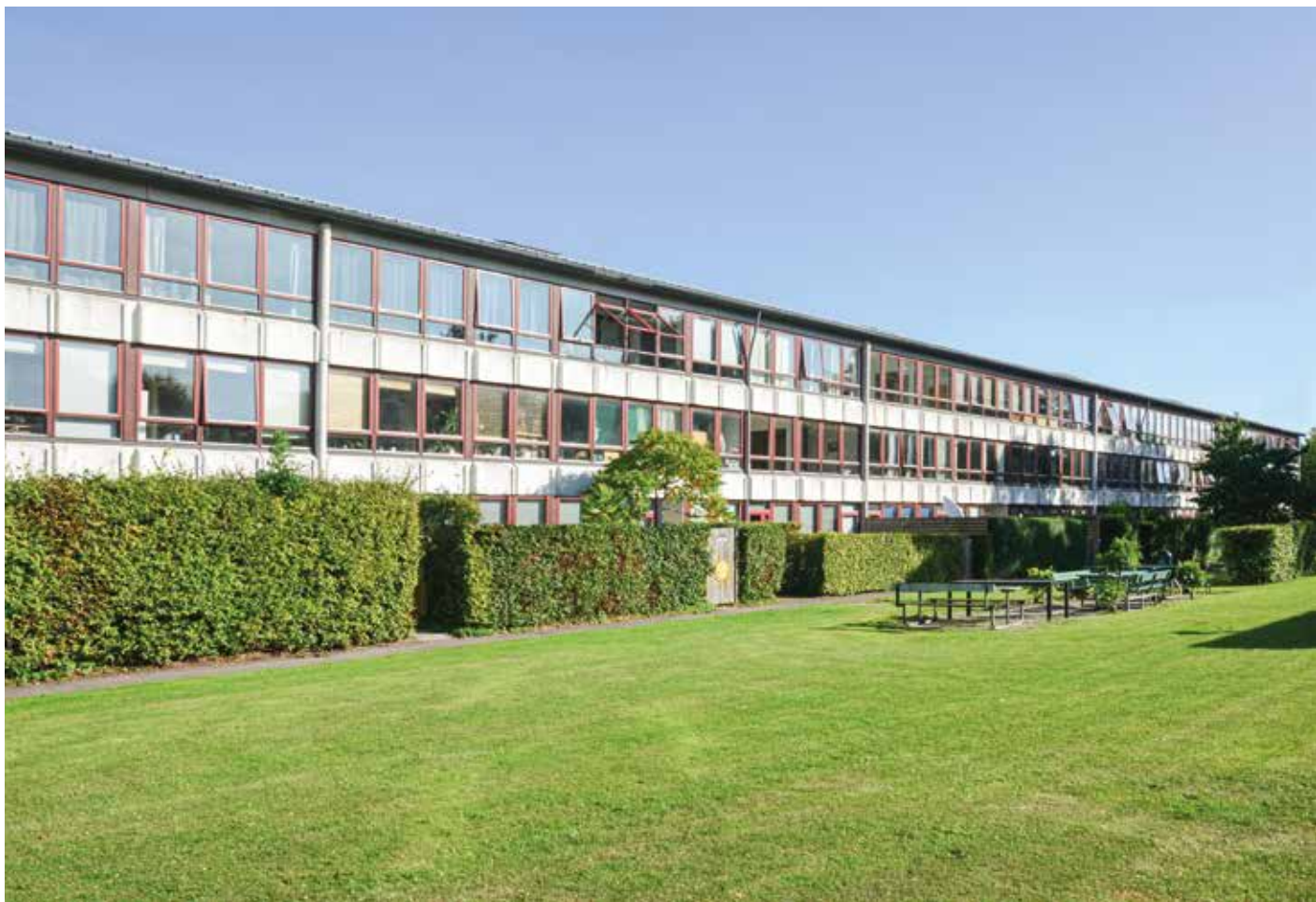
Et aktuelt foto fra Egeparken 1. Renoveringen vil ske i etaper, hvor beboerne genhuses. Blandt andet i de renoverede boliger.
